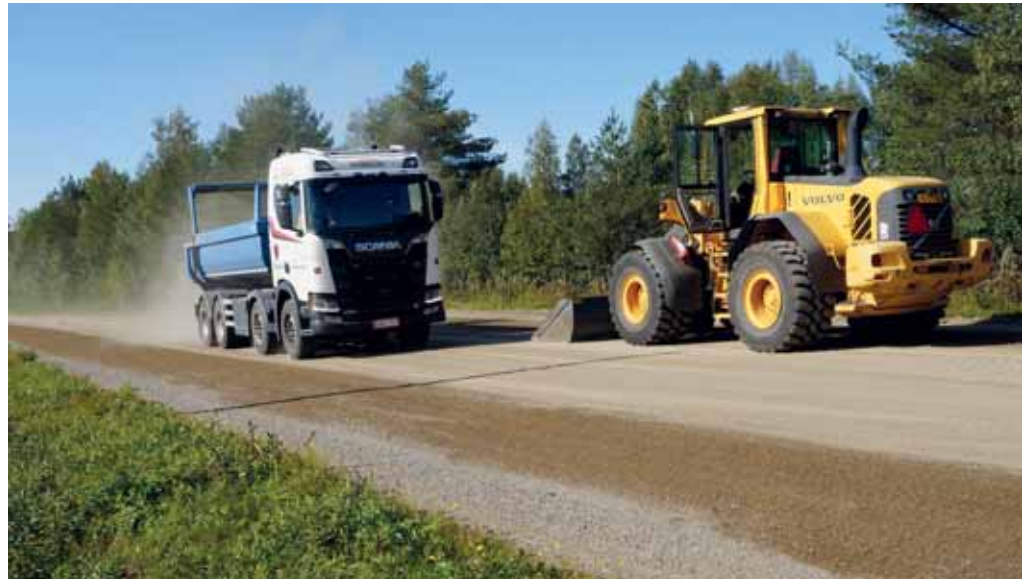
Raviradalle levitetyn soran raekoon on oltava tarkoin vaatimusten mukaista. Hienojakoisin aines pölyää taivaan tuuliin. Hannu Vuokila tasoitti sora-aineksen järeän kauhan avulla.
