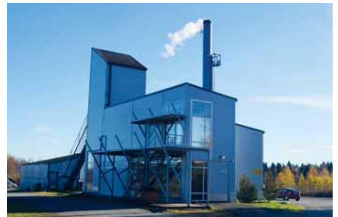
Kaukolämpölaitoksen tuottama lämpöenergia saadaan aikaan hakkeella.
