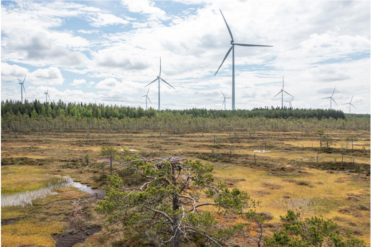
Kuva 7.2. Esimerkkikuva tuulivoimaloista (Kuva: Myrsky Energia Oy/Ville Suorsa).
