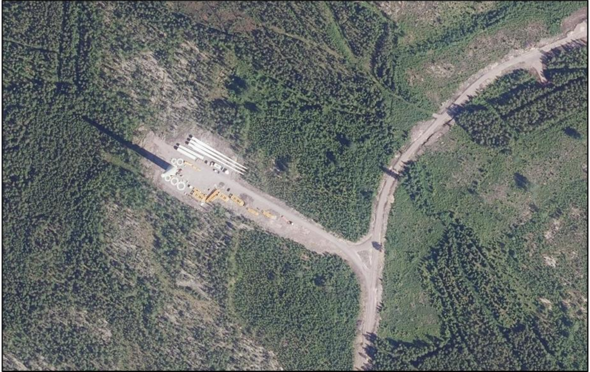
Kuva 7.4. Esimerkkivalokuva rakennusvaiheessa olevan tuulivoimalan pystytys – ja työskentelyalueesta.
