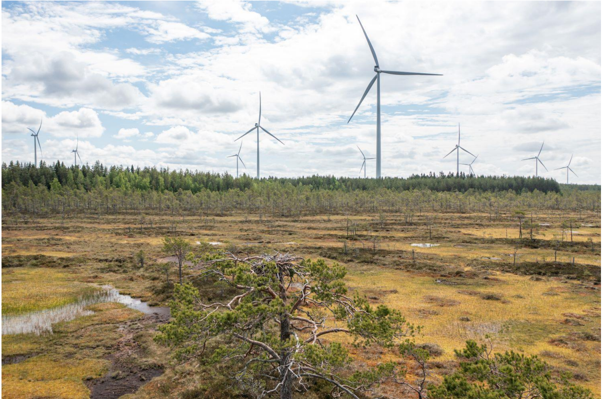
Kuva 7.2. Esimerkkikuva tuulivoimaloista (Kuva: Myrsky Energia Oy/Ville Suorsa).
