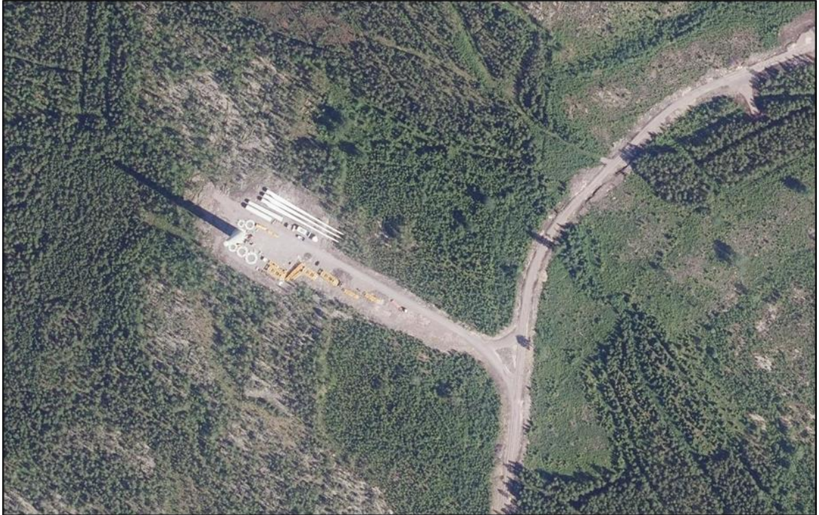
Kuva 7.4. Esimerkkivalokuva rakennusvaiheessa olevan tuulivoimalan pystytys – ja työskentelyalueesta.
