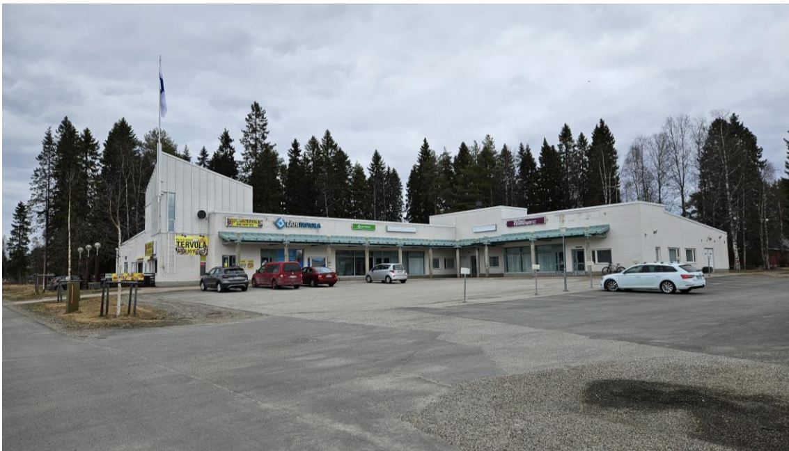
4. Rakennus, jossa sijaitsee päiväkotiki sekä muita palveluja.
