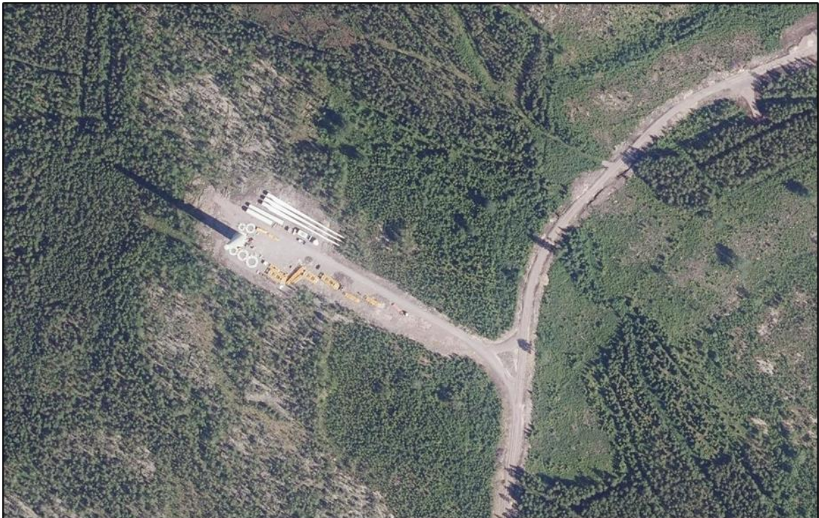
Kuva 7.4 Esimerkkivalokuva rakennusvaiheessa olevan tuulivoimalan pystytys – ja työskentelyalueesta.
