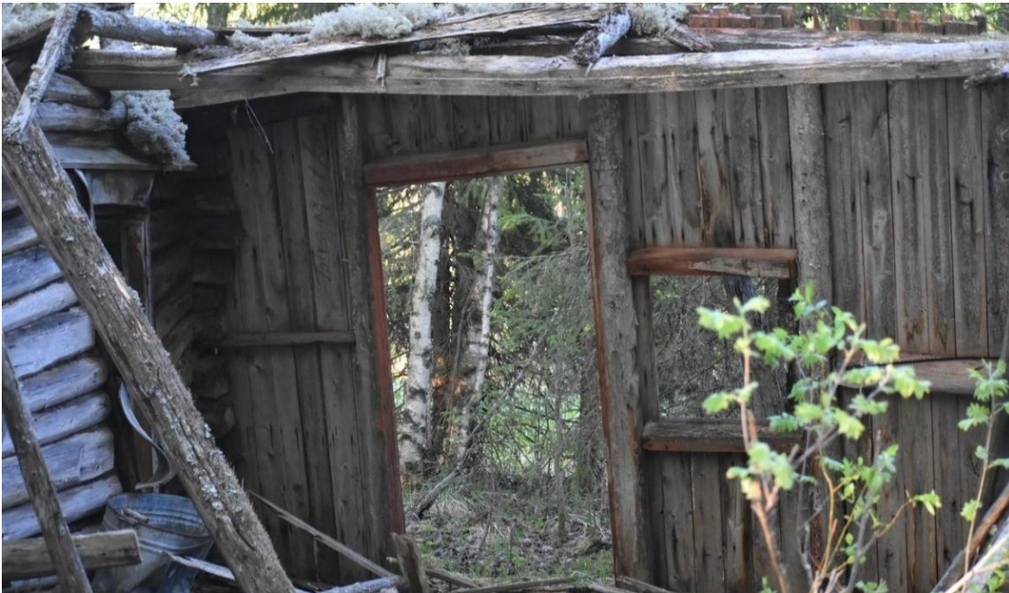
Kuva 31. Olkkosen vanha tila Vaajoen itäpuolella, Pirttikosken kohdalla.
